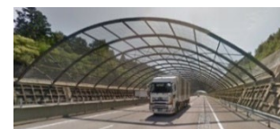
GPS精度低下区間の例(金属ネット)
