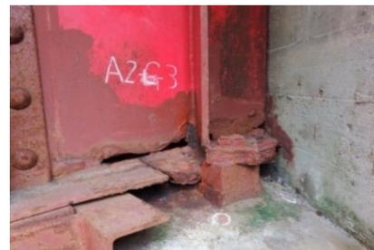
桁端部の腐食・貫通
