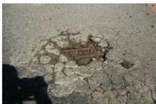
(床版上面) 舗装土砂化
